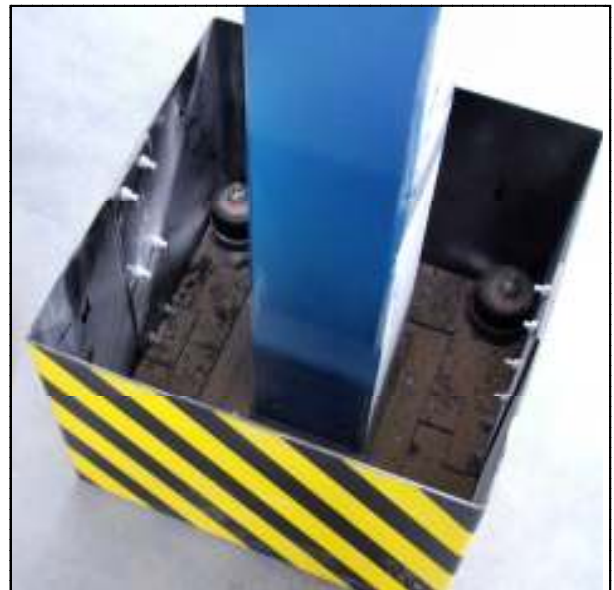
Ochrona słupów hali
